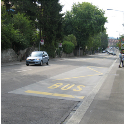
Betonplatte bei Bushaltestelle
