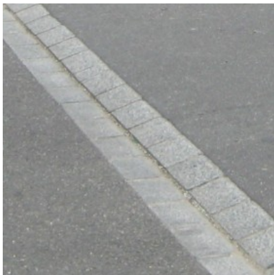
Schalenstein schräg ohne Anschlag
