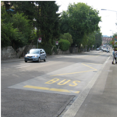
Betonplatte bei Bushaltestelle
