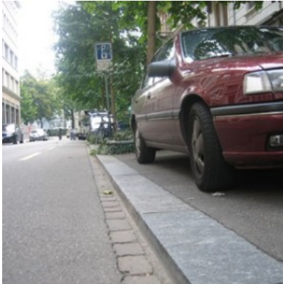
Abgesenkter Randstein vertikal
