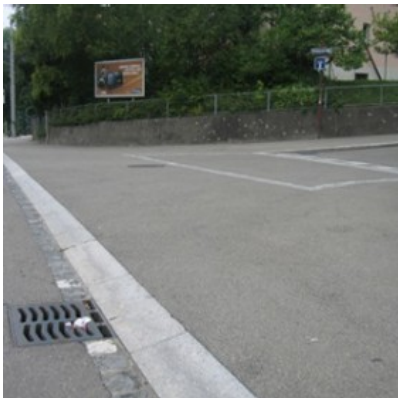
Abgesenkter Randstein schräg ohne Anschlag
