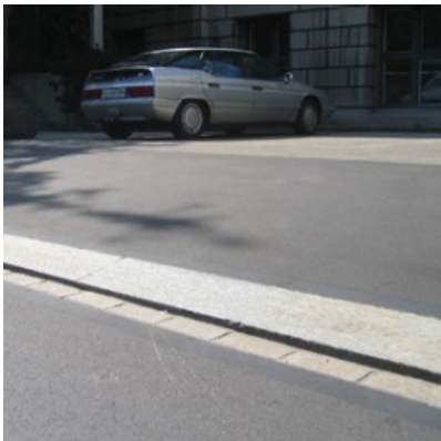
Abgesenkter Randstein schräg mit Anschlag
