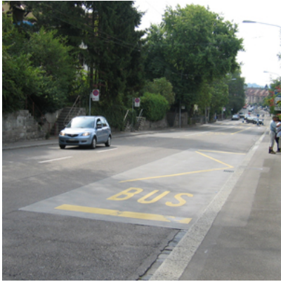
Betonplatte bei Bushaltestelle
