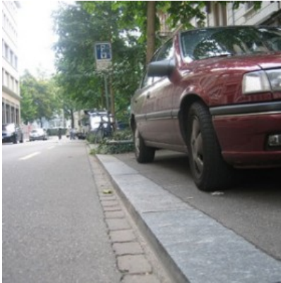
Abgesenkter Randstein vertikal
