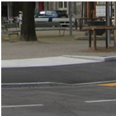
Granitplatten bei Rampen
