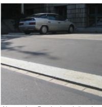
Abgesenkter Randstein schräg mit Anschlag
