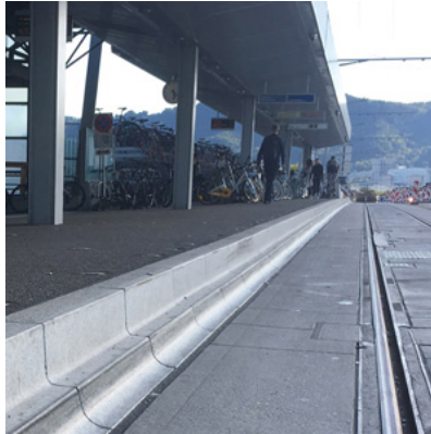
Kombinierte Tram- und Bushaltestelle mit Zürich-Bord 28cm
