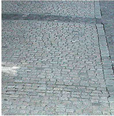
Reihenpflasterung aus Quarzsandstein
