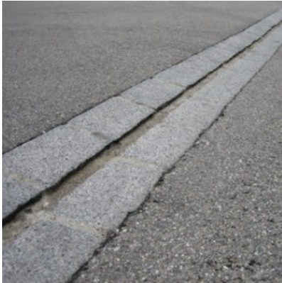
Schalenstein schräg mit Anschlag
