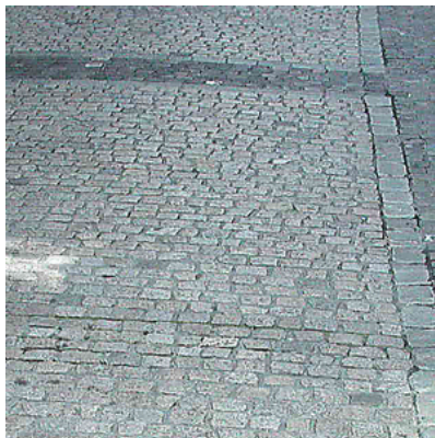
Reihenpflasterung aus Quarzsandstein
