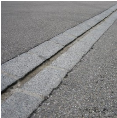
Schalenstein schräg mit Anschlag
