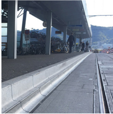
Kombinierte Tram- und Bushaltestelle mit Zürich-Bord 28cm
