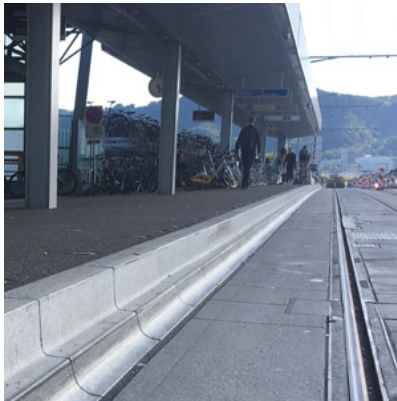
Kombinierte Tram- und Bushaltestelle mit Zürich-Bord 28cm
