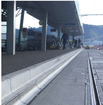
Kombinierte Tram- und Bushaltestelle mit Zürich-Bord 28cm
