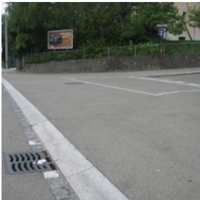
Abgesenkter Randstein schräg ohne Anschlag
